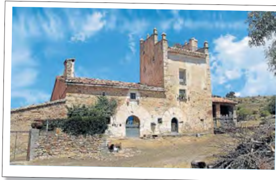
Masía fortificada de Torre Pintada, situada en Puertomingalvo. HA
